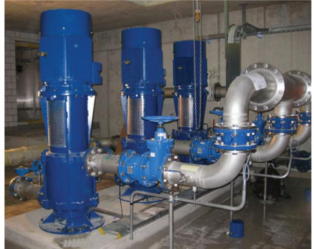
Bei der Baureihe HPZ handelt es sich um horizontale oder vertikale, mehrstufige Kreiselpumpen in Gliederbauweise.
